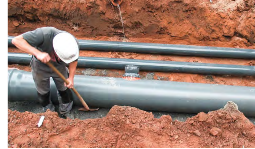
Für Sanierungen in offener Bauweise, wird der Boden aufgedeckt.
