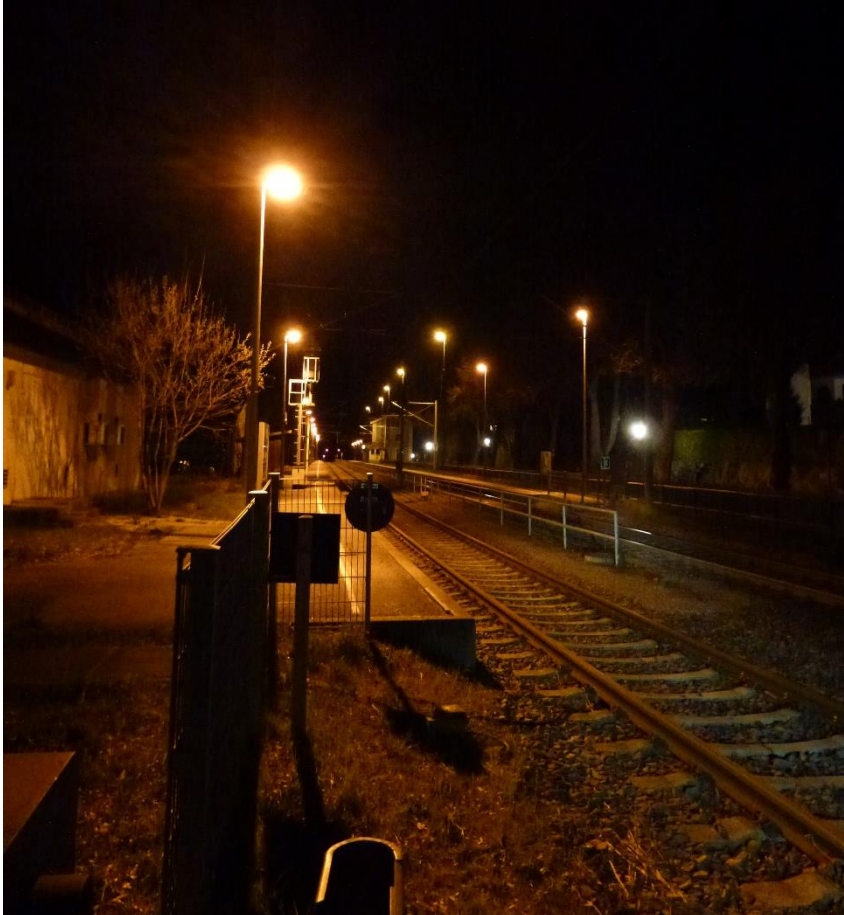
Bild 11: Bahnhofsanlage Uffing, warmweiße LED-Beleuchtung
