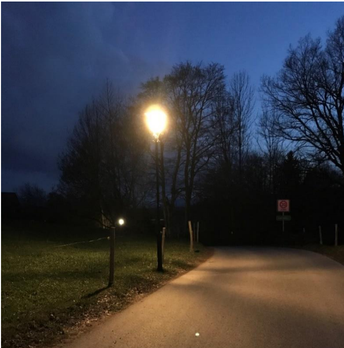
Bild 4: Testlampe in Schöffau Richtung Kalkofen mit 30 Watt LED-Leuchtmittel
