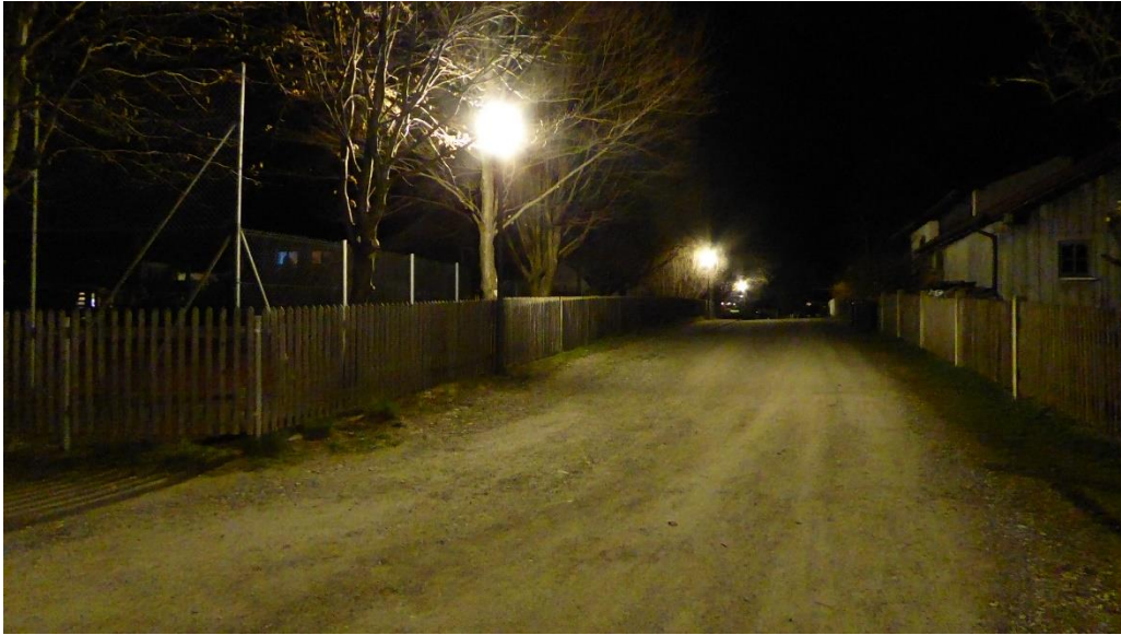
Bild 9: Heimgartenstraße 11. Bavaria-Leuchten (54 W Leistung) Leuchtstofflampen 3000K
