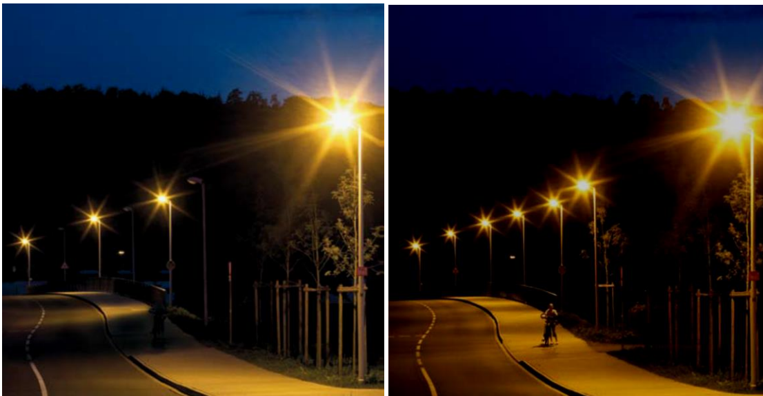
Bild 15: Durch das Abschalten jeder zweiten Leuchte entstehen sogenannte Tarnzonen (links). Tarnzonen stellen eine große Unfallgefahr auf Verkehrswegen dar. Durch das gleichmäßige Herunterregeln aller Leuchten können diese vermieden werden. (Licht. Wissen 03)
